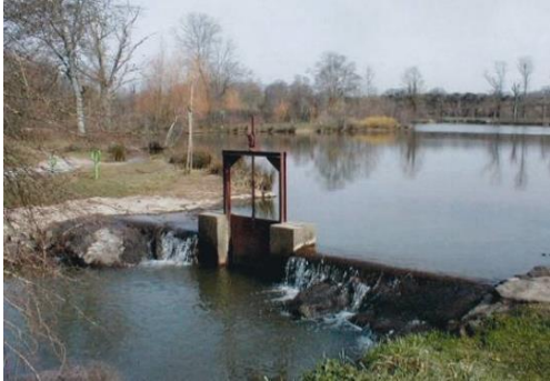
Alluchon Été 2011 Travaux en 2018
